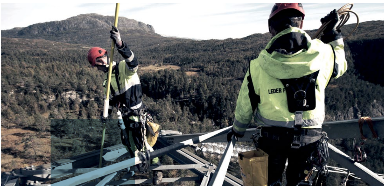
Arbeid på kraftmaster, Statnett. Foto: Johan Wildhagen
