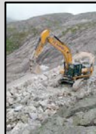
Plastring på fyllingsdam
