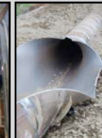
Løpende brudd i CO 2 -rør
