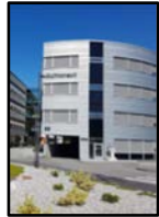
Ventilasjon i passivhus
