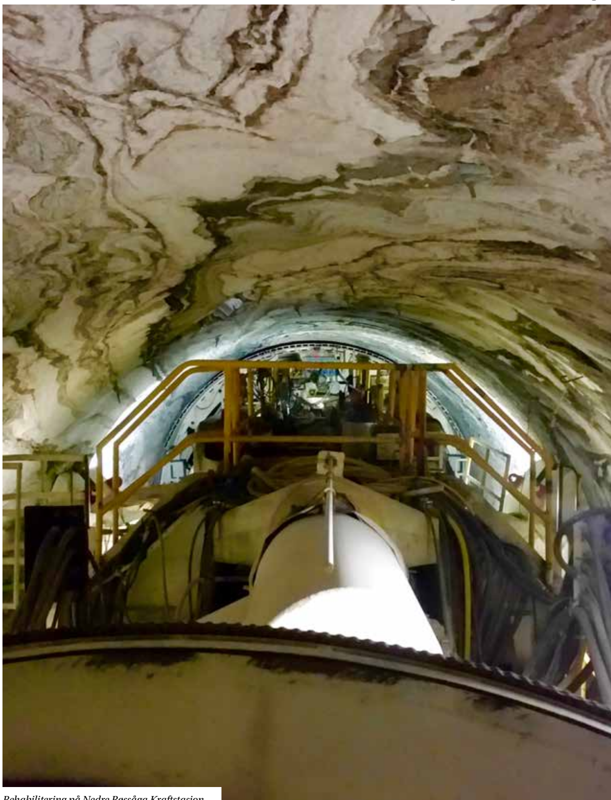
Rehabilitering på Nedre Røssåga Kraftstasjon.
