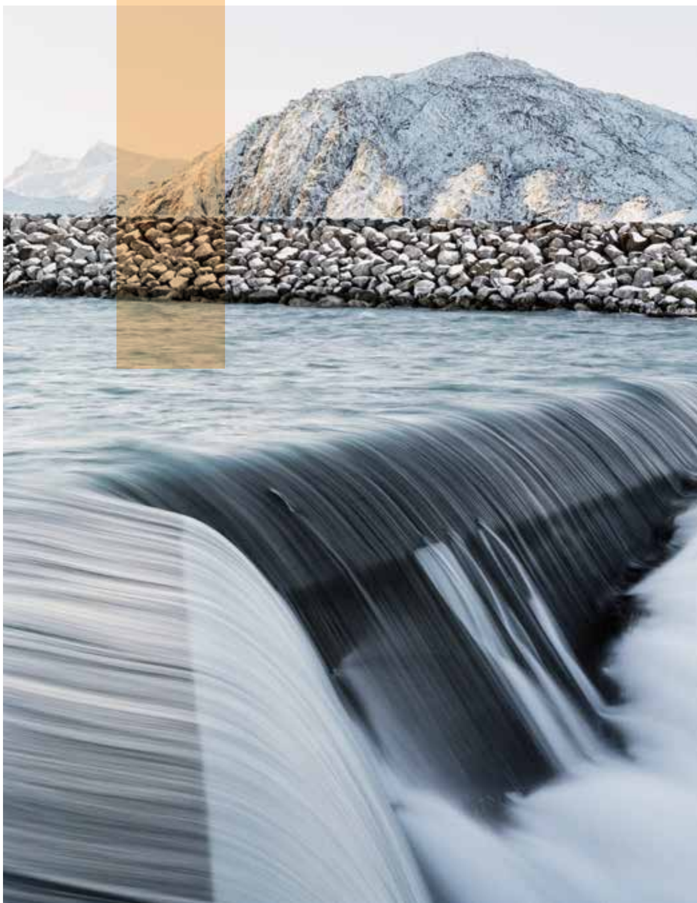
Holmvassdammen, Svartisen kraftstasjon, Statkraft. Foto: Christian Hauge
